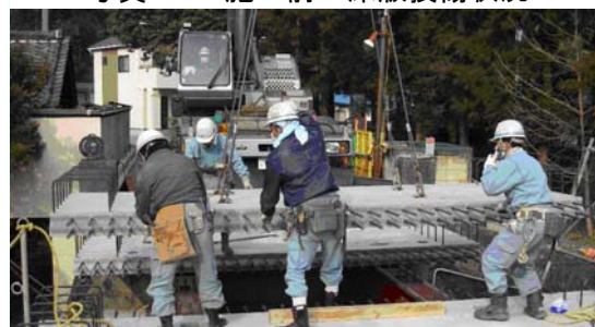
写真-3 SLJスラブ架設
