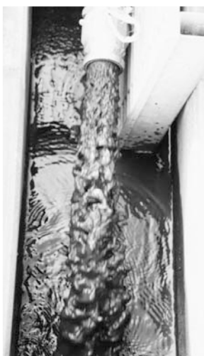
洗管で排出される黒い濁水
