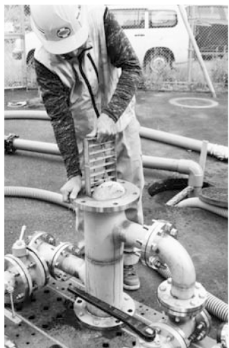
洗管後のピグを取り出す様子
